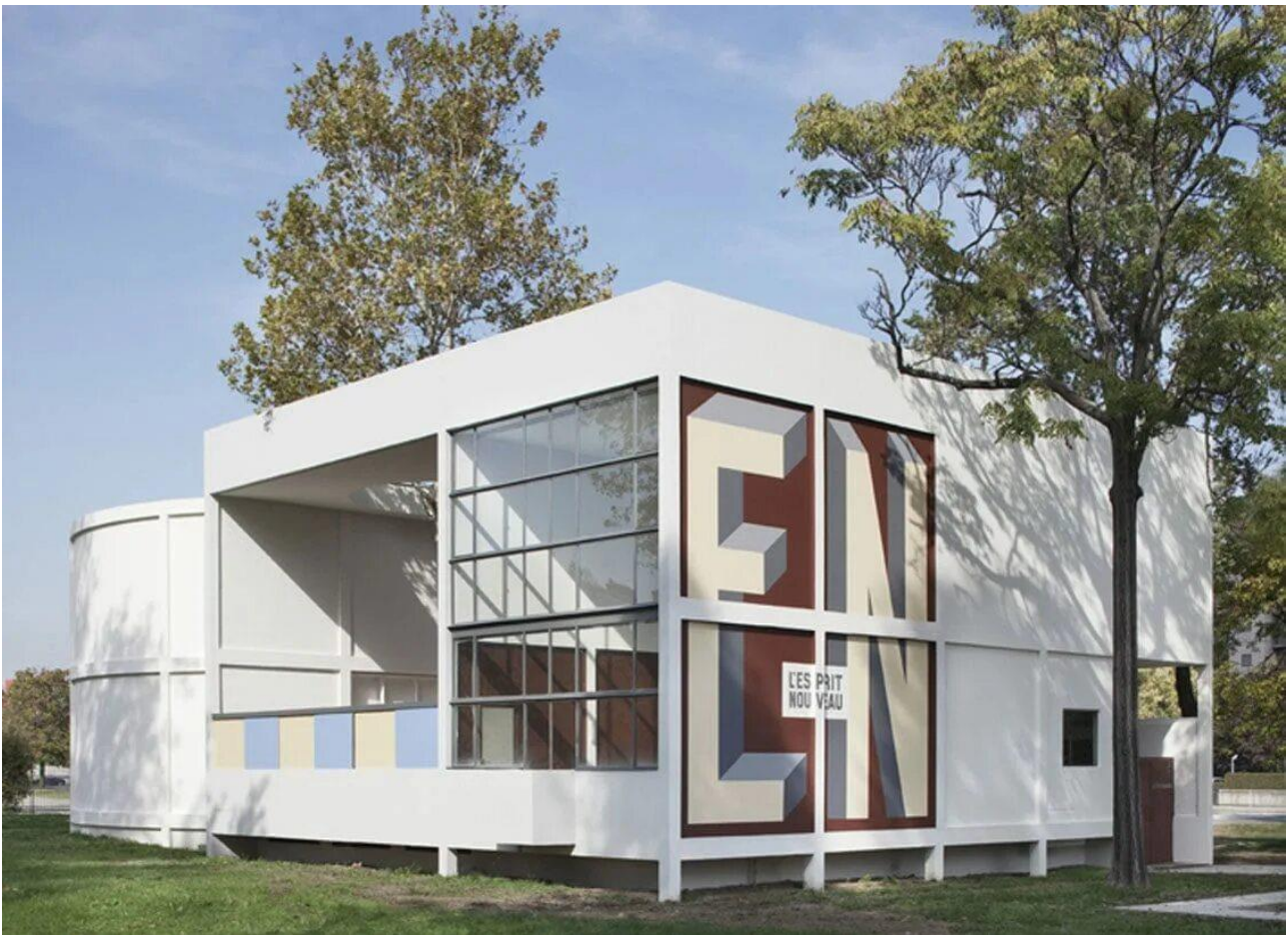
Павильон Эспре-Нуво в Париже (1950 г.), архитектор Ле Корбюзье
