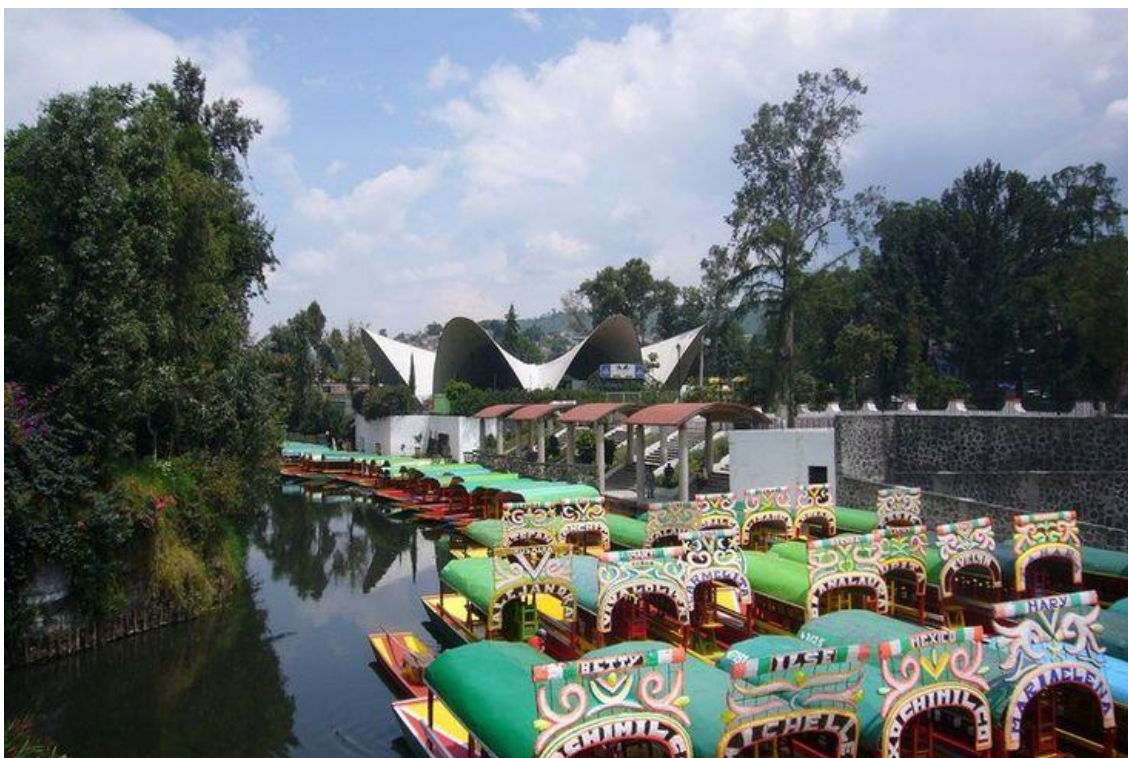
Los Manantiales – каменный цветок — ресторан в районе Ксохимилоко Мехико, 1958г., Мексика, архитектор Феликс Кандела
