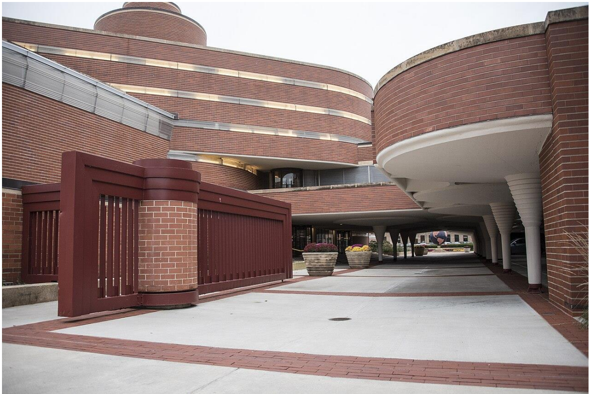
Штаб-квартира Johnson Wax, 1936-1939 г.г., архитектор Франк Ллойд Райт
