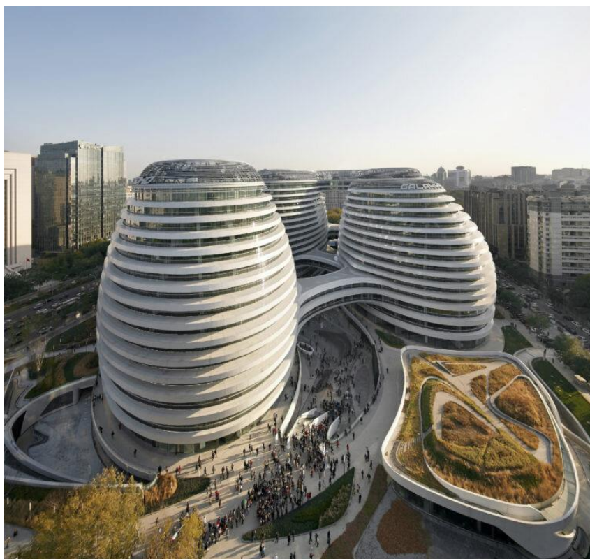
Торгово-развлекательный комплекс Galaxy Soho, Пекин, 2012г., архитектор Заха Хадид
