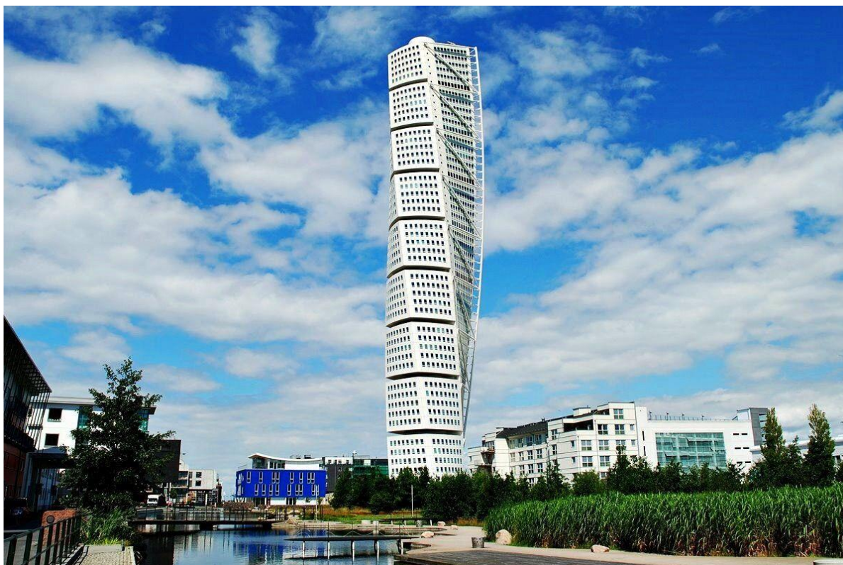
Здание Turning Torso, 2012г. г. Мальмё, Швеция, архитектор Сантьяго Калатрава
